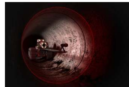
Inspección Interna de Redes
